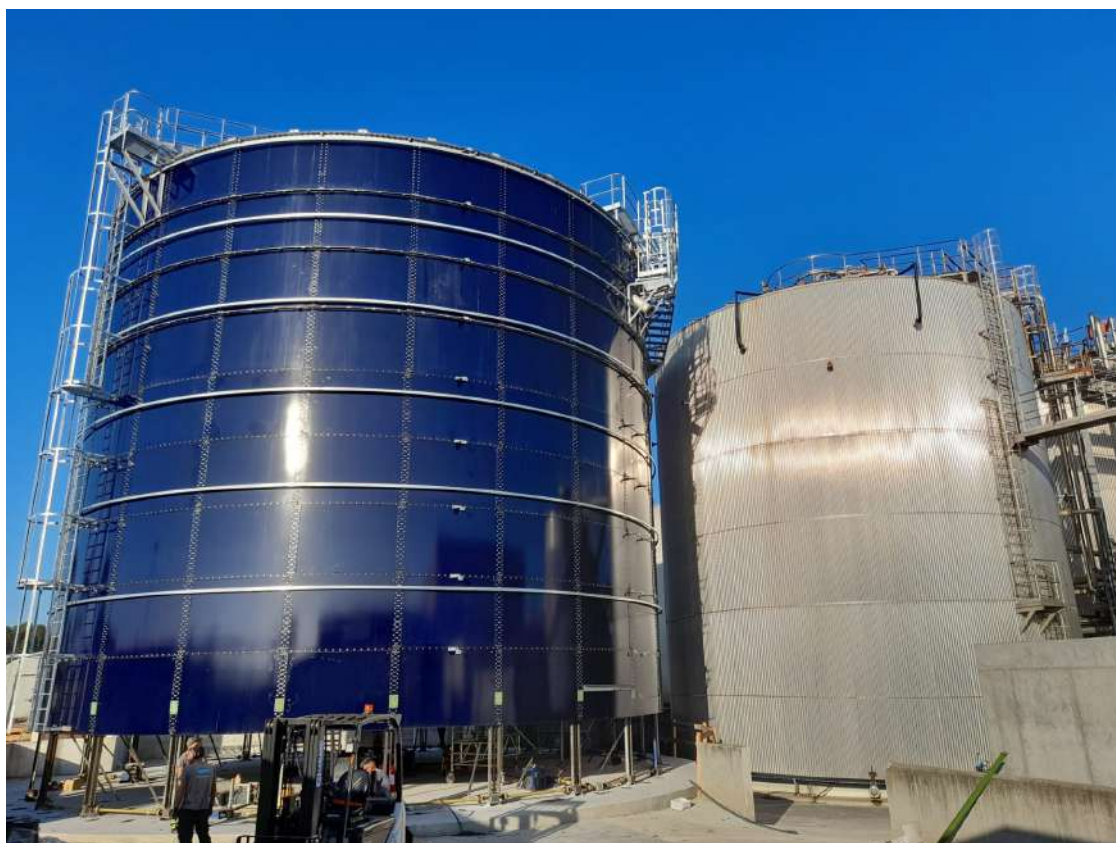
Figura 19. Construção do 3º digestor para o tratamento de biorresíduos da recolha seletiva
