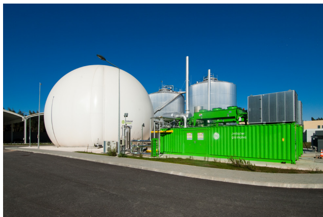
Figura 19. Motor de biogás e gasómetro
