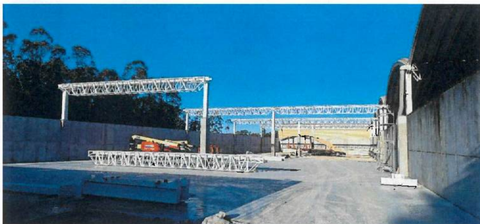
Figura 20 – Construção da Pós-compostagem
